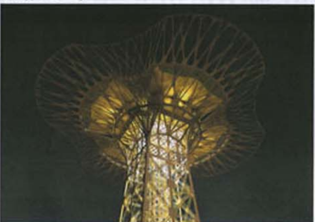
Ażurowy „kolejny” wieży
